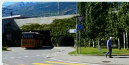
Plantations et végétalisation d'un mur sous les voies CFF en gare de Brig
