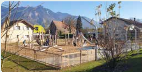
La nouvelle place de jeux des Evouettes (Port-Valais) intègre mobilier en bois, bandes herbeuses plantées d'essences indigènes, point d'eau et pergola végétalisée, Atelier Grept, 2020
